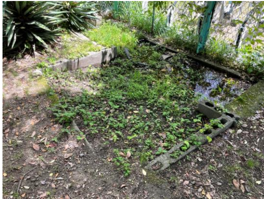
コンクリート構造物
