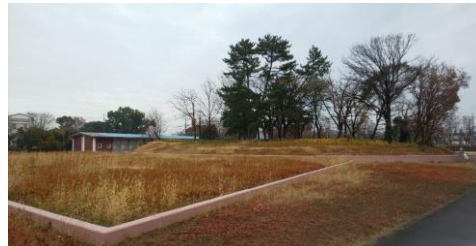
範囲を擁壁で示した前方部
