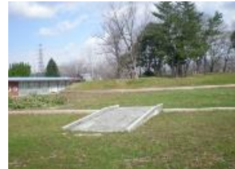
前方部端のスロープ
