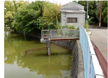
2箇所に設置された樋 (写真は東側)
