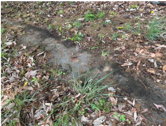
コンクリート構造物
