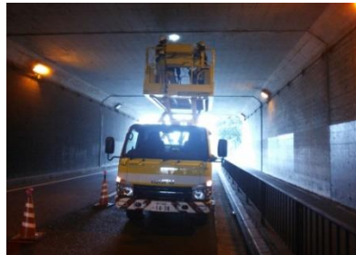
トンネル点検
