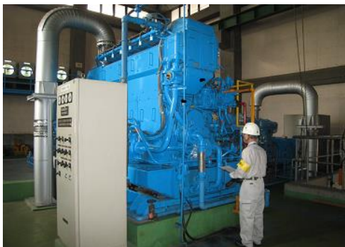
内川排水機場年次点検状況
