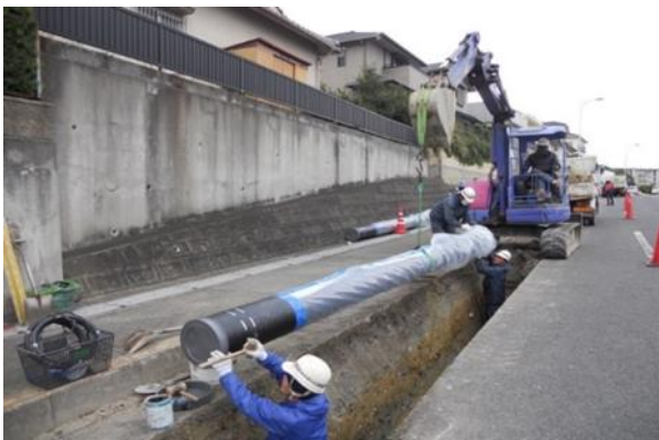
水道管の更新
