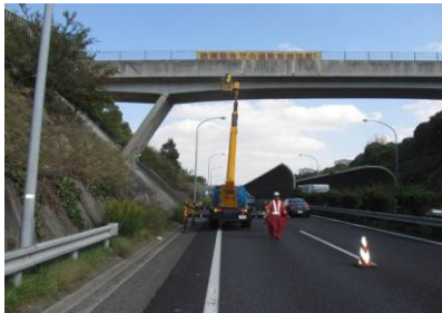
橋りょう点検
