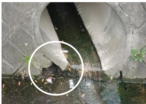
護岸損傷状況
