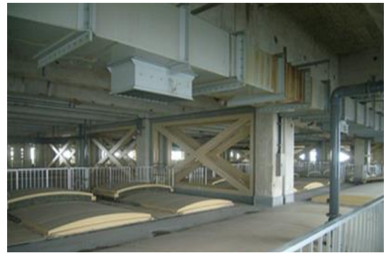
施設耐震化工事
