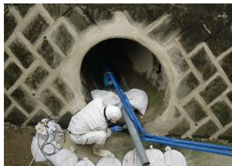
護岸補修状況
