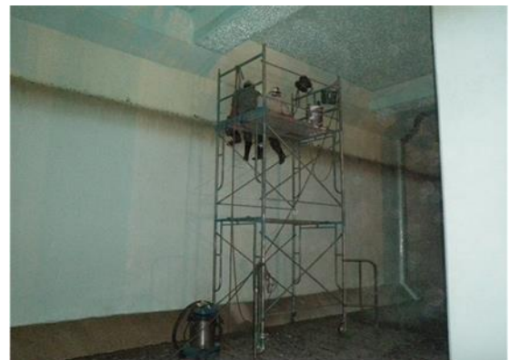
配水池内の点検・調査
