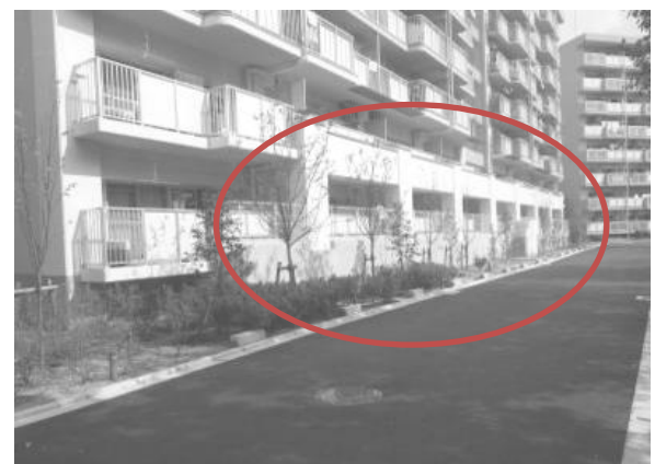
■公営住宅の耐震改修
