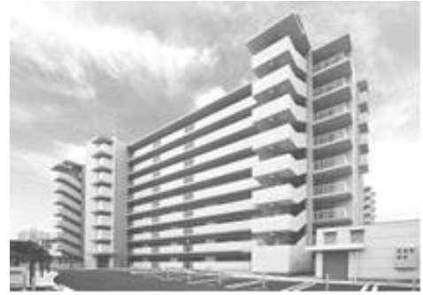
■市営住宅(建替住宅)
