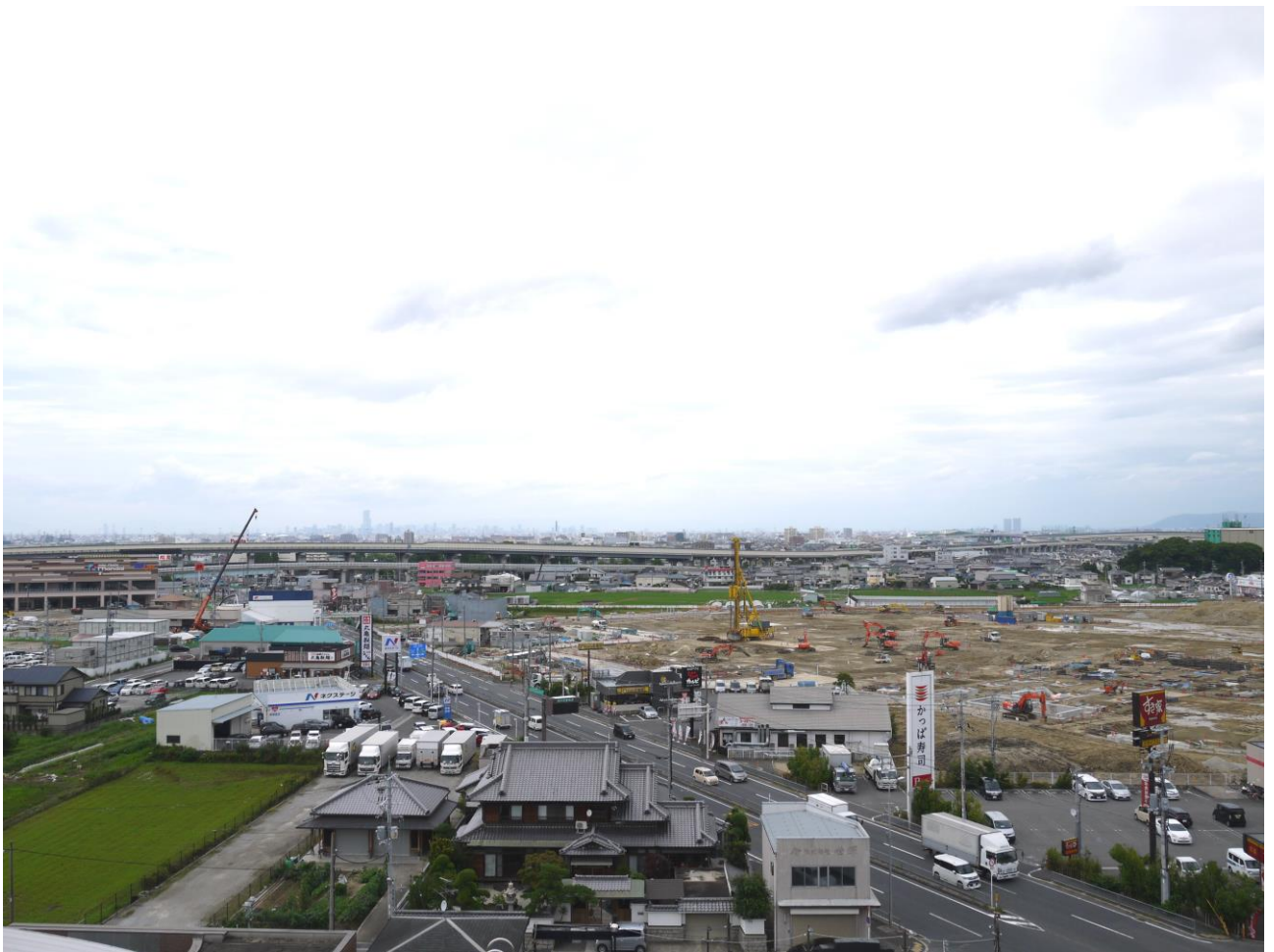
令和3年6月 美原区役所本館屋上より撮影
