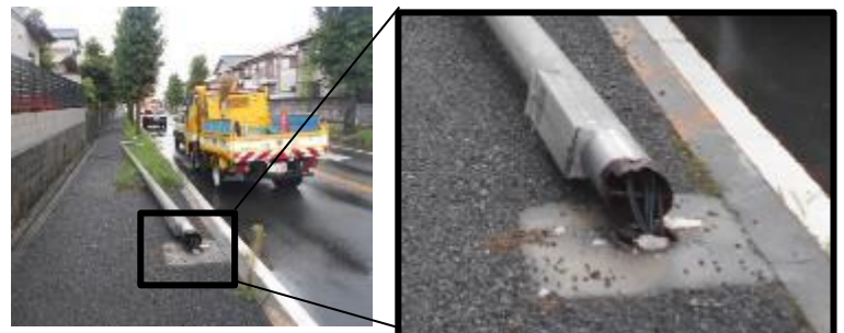
基部の腐食により倒壊した道路照明灯
