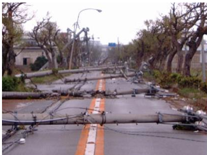
写真 3-1 災害による電柱倒壊事例 (出典：国土交通省 HP)
