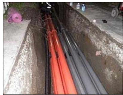
図 9-1 浅層埋設方式の整備事例 (出典：国土交通省 HP)
