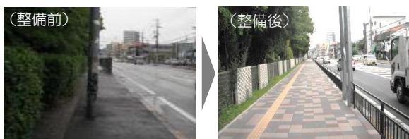
歩道の有効幅員拡幅、横断勾配の改善、障害物の撤去、視覚障害者誘導用ブロックの設置などを整備
