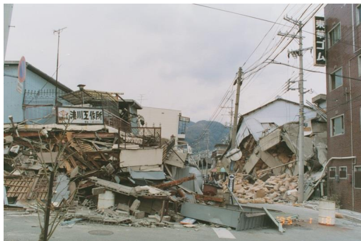
図-9 建物倒壊による道路閉塞の事例 (写真提供：神戸市)
