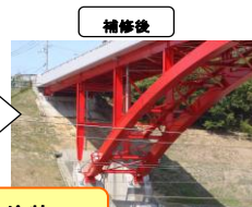
施工例) 塗替塗装工
