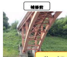
施工例) 塗替塗装工
