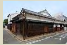
歴史的建造物の修復
