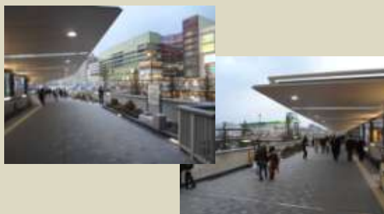
ペDESTリアンデッキの改修・再整備
