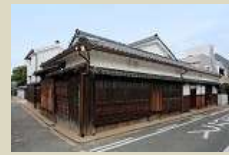
歴史的建造物の修復
