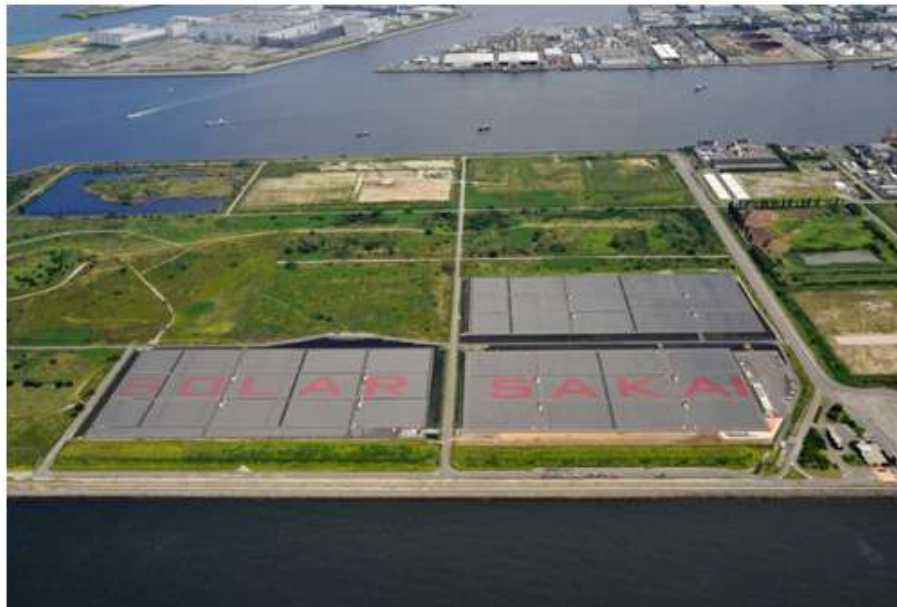
堺太陽光発電所
