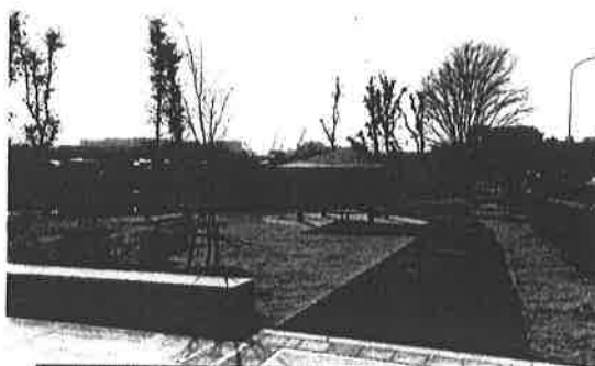
完成した「新岸池周遊路」
