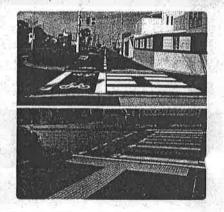
泉北1号線沿いの歩道(約450メートル)の 凸凹道を美しく舗装し、点字パネル、自転車 道等の路面表示で通行し易くなりました。
