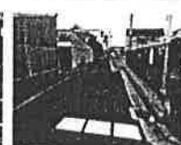
小寺地区内下水配管および道路舗装
