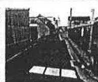
小寺地区内下水配管 および道路舗装
