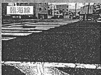
臨海線 大型車の通行の度に振動を起していた路面の凹凸を舗装。
