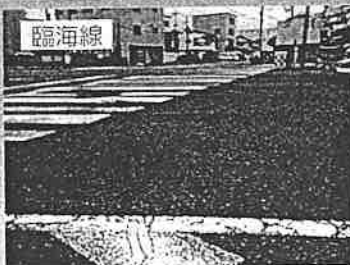
大型車の通行の度に振動を起こしていた路面の凹凸を舗装。
