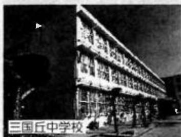
エアコンの効が悪い最上階の教室の天井を断熱工事。
