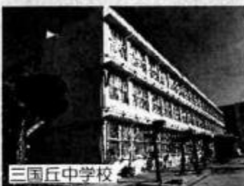
エアコンの効が悪い最上階の教室の天井を断熱工事。
