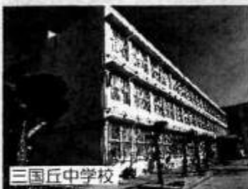
三国丘中学校 エアコンの効きが悪い最上階の教室の天井を断熱工事。
