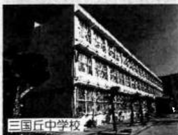
三国丘中学校 エアコンの効きが悪い最上階の教室の天井を断熱工事。
