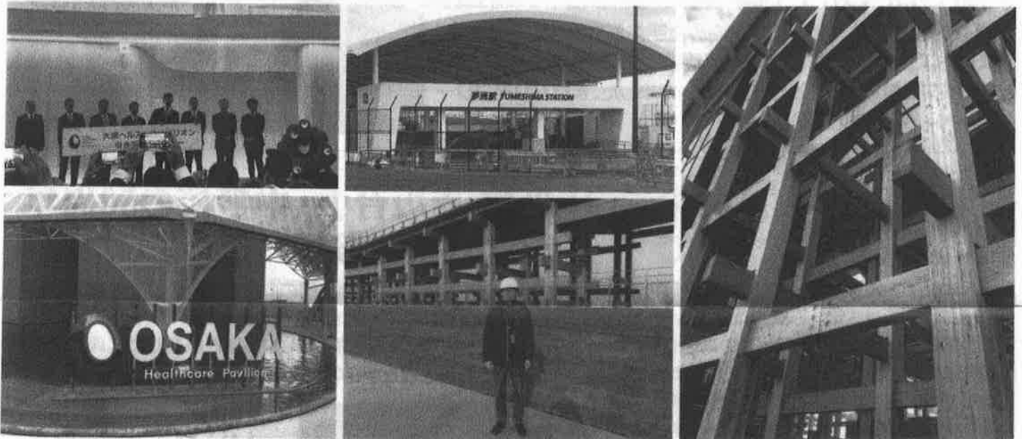
1つにつながった大屋根、各パビリオンが急ピッチで整備されています。
