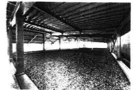
バイオフィルターは、臭いを含んだ空気が木質チップ層を通過することにより、吸着されたり、微生物に分解されることで脱臭が行われます。木質チップの間隙には生物膜(バイオフィルム)が形成され、臭いをエサとして微生物がさかんに呼吸=酸化分解を行います。木質表面の酸化生成物は、上部からの散水により洗い流されます。この水は循環していますので、絶えず微生物による分解が行われます。
