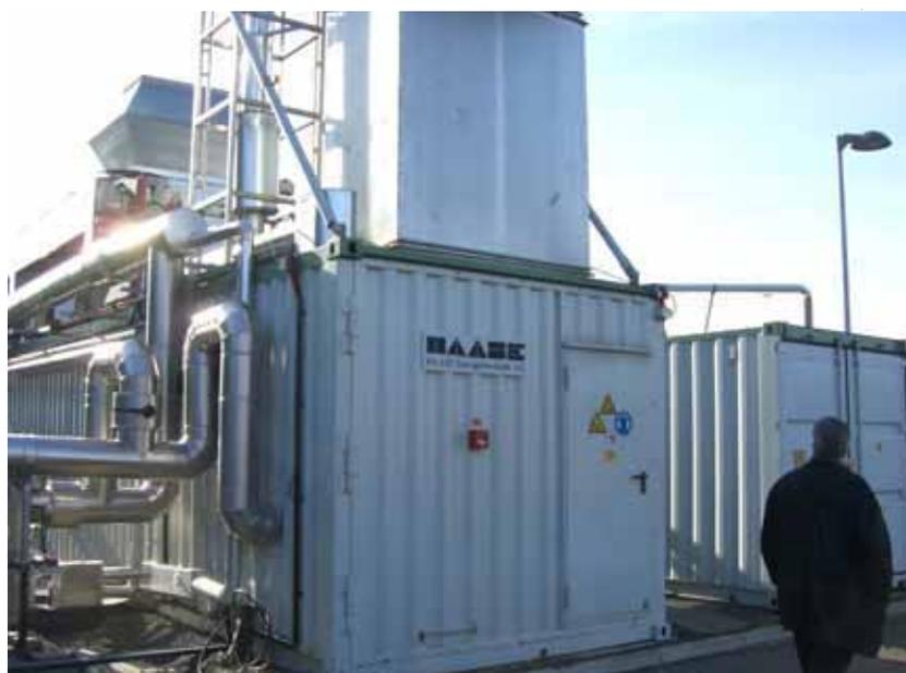
○説明者 こちらで水分だけを取って、冷却したぐあいで水分が取れて、圧縮されたガスが中に入って燃えて、燃えるのが石油のかわりで、それでモーターを動かします。
