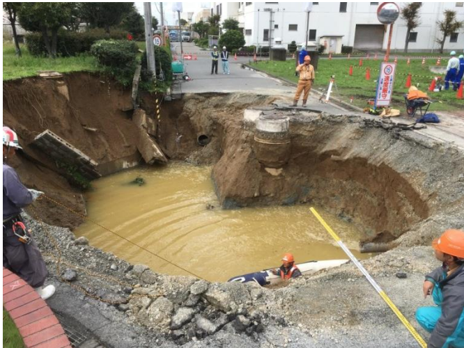
道路陥没の状況
