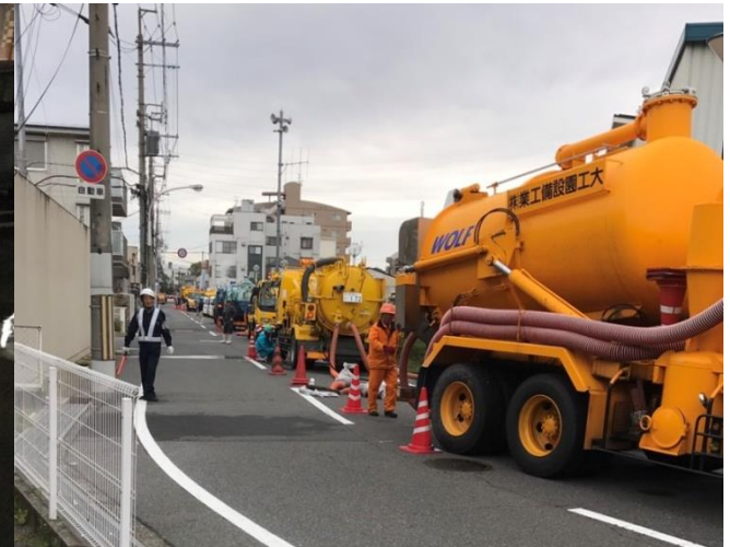
下水吸引作業
