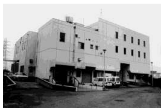
浜寺下水ポンプ場
