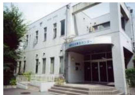
生活衛生センター
