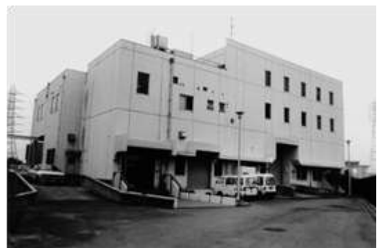
浜寺下水ポンプ場
