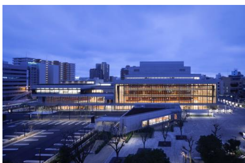
フェニーチェ堺 外観
