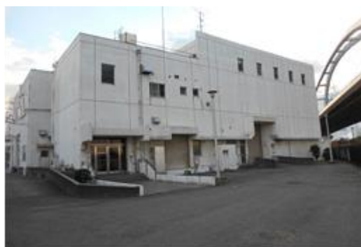
浜寺下水ポンプ場
