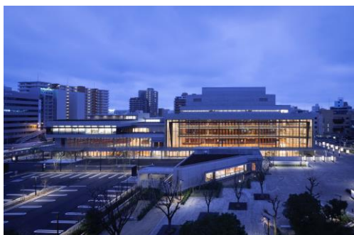
フェニーチェ堺 外観
