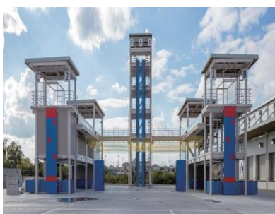
総合防災センター (救助訓練棟)
