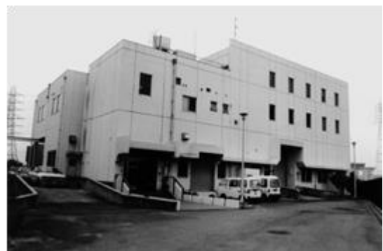
浜寺下水ポンプ場
