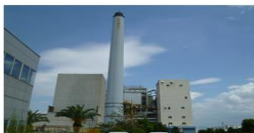
クリーンセンター東工場第一工場
