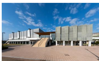
大浜体育館・大浜武道館
