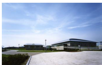
原池公園体育館
