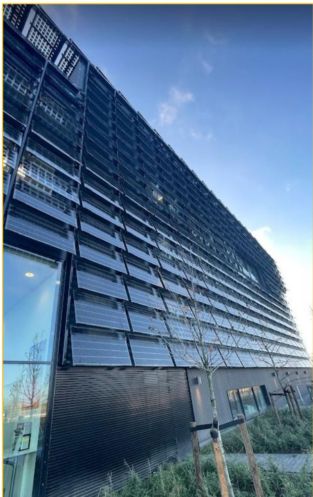
外壁にソーラーパネル
