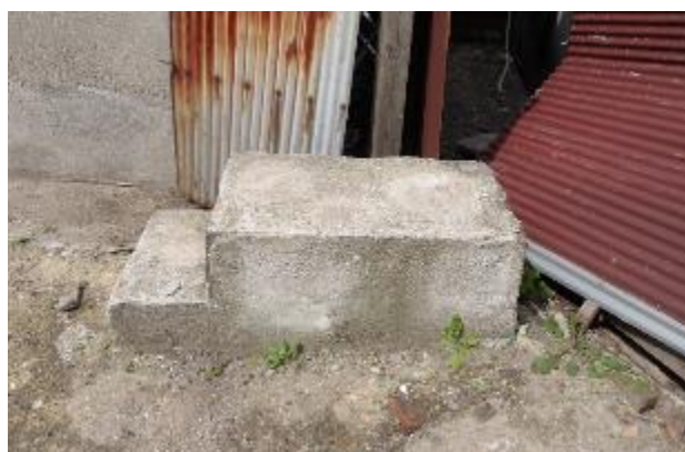
特記事項④：階段状のコンクリート構造物
