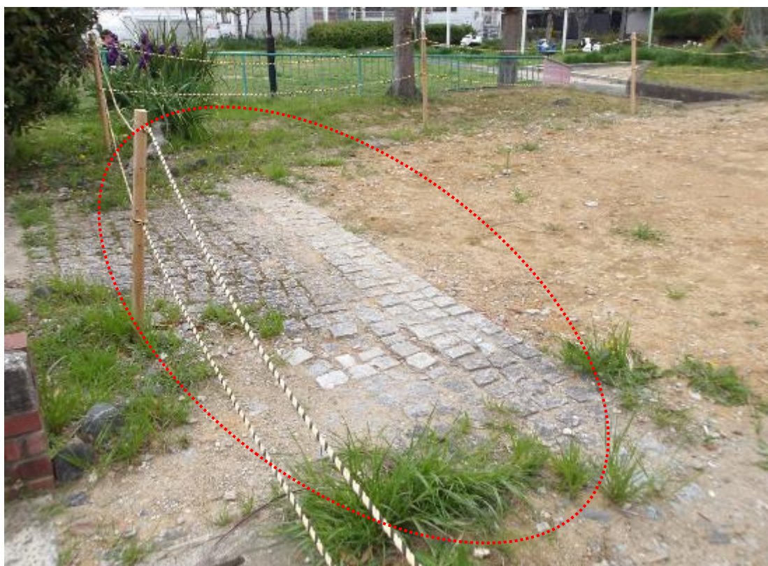
特記事項⑥：敷地南側の埋設ブロック
