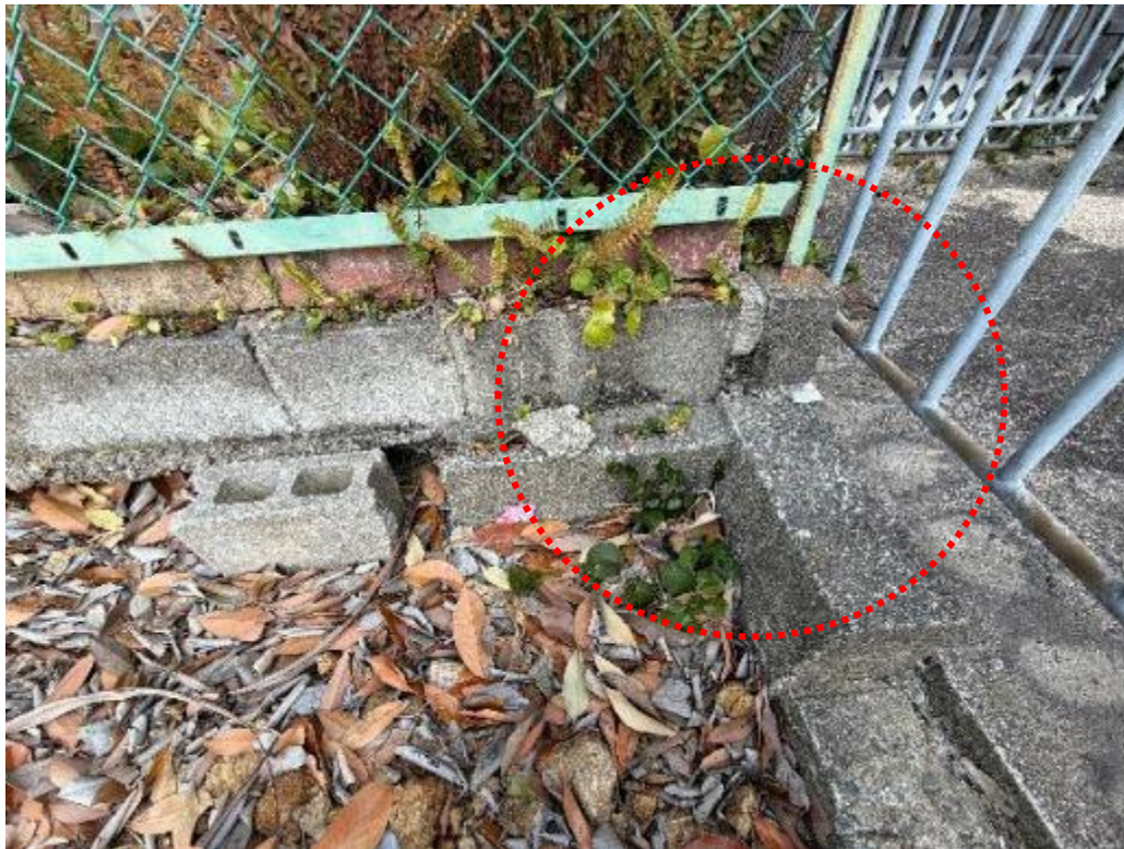
特記事項④：北側隣接地との境界付近（コンクリートブロック）
