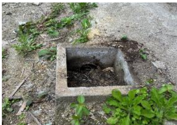
特記事項⑤：柵状のコンクリート構造物
