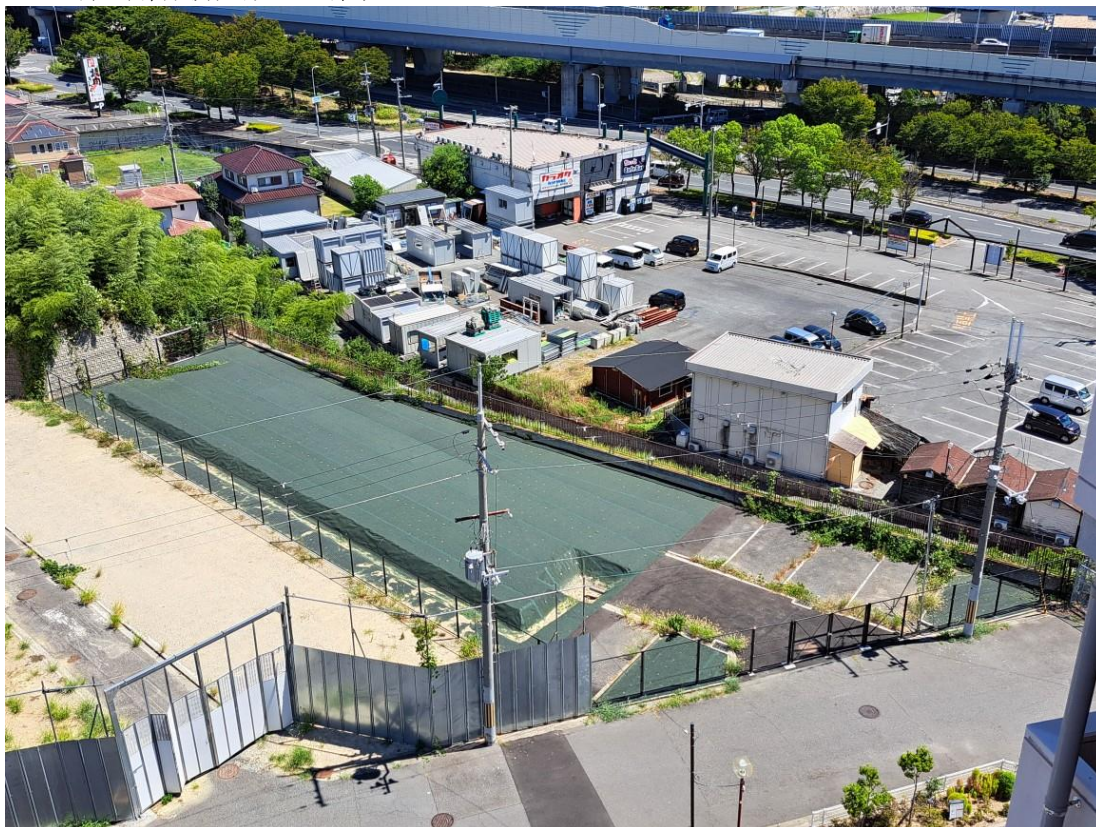
③から旧P棟（解体済）敷地を撮影
