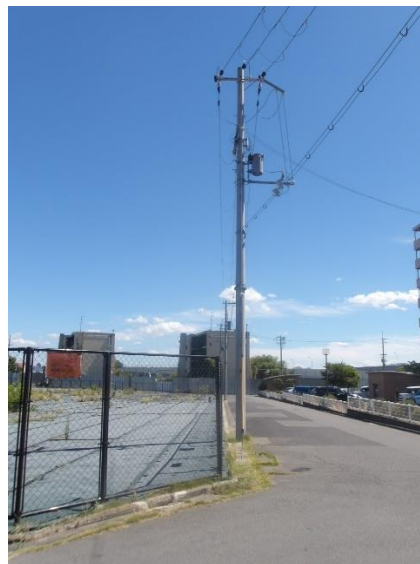
⑩から上空の一部を占有する架空線を撮影
