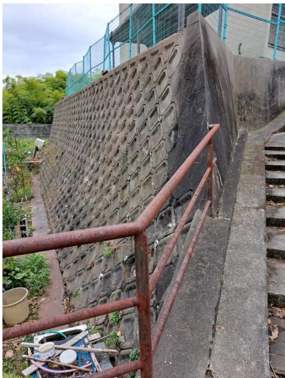
⑲から擁壁（高低差約 5.4m）を撮影
