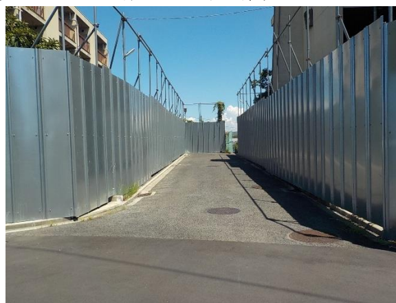
⑯から里道への敷地内通路を撮影
