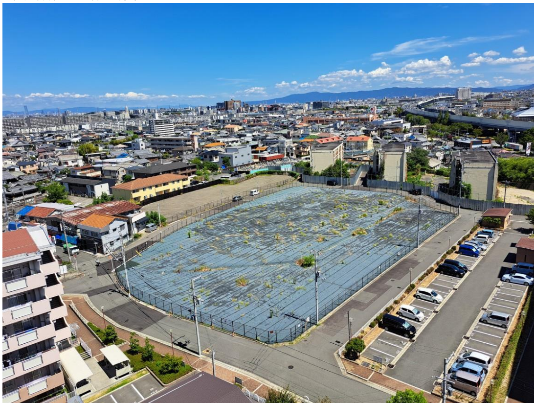
①から本物件敷地全体を撮影
