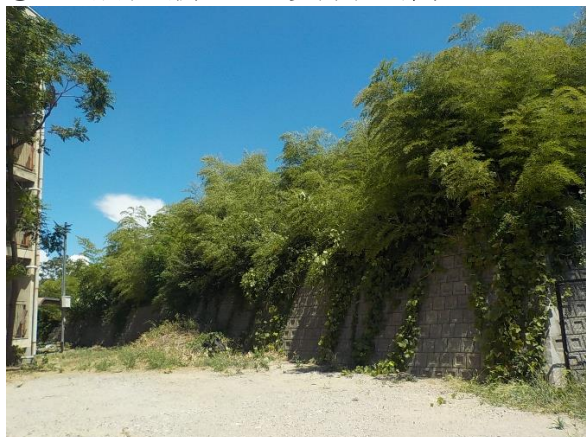
⑪から南東側隣地の越境樹木を撮影
