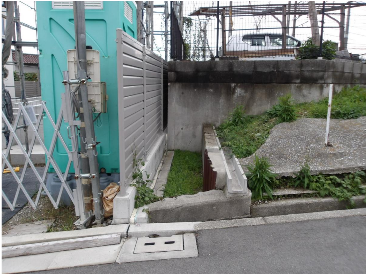
①の位置から擁壁設置工事部分を撮影
