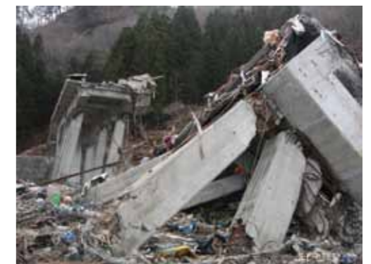
崩壊した島越駅
