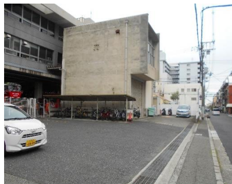
倉庫棟（写真②）
