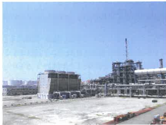
建設予定地写真
