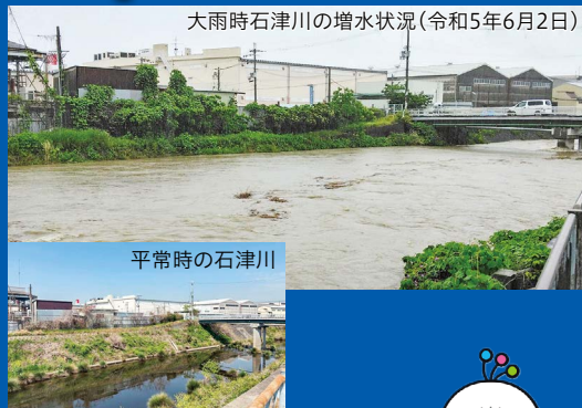
大雨時石津川の増水状況(令和5年6月2日)
