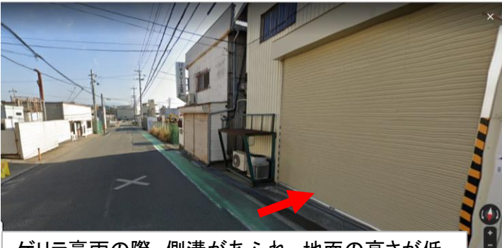
ゲリラ豪雨の際、側溝があふれ、地面の高さが低い民地に流れ込んだ。
