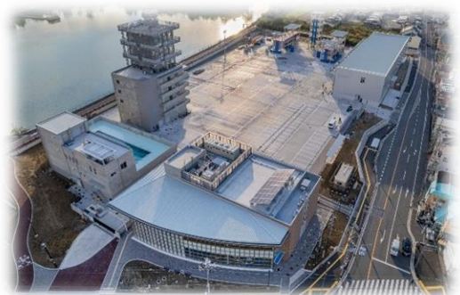
【堺市総合防災センター】
