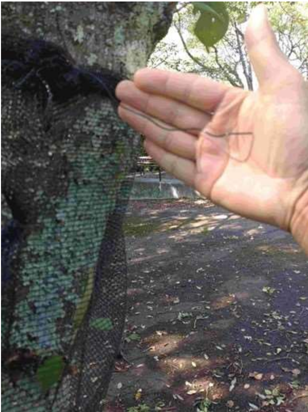
悪例③針金端部処理無。飛び出ているので公園等利用者のケガの元となる。
