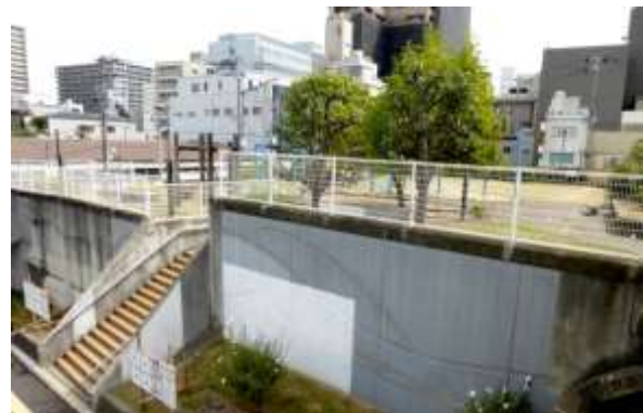
人工地盤上の公園(下部は地下自転車等駐車場)
