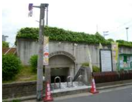
地下自転車等駐車場
