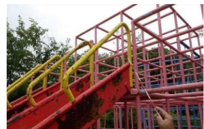
写真：老朽化した遊具
