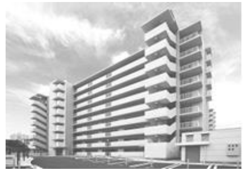
■市営住宅(建替住宅)
