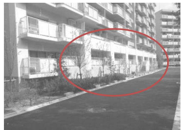
■公営住宅の耐震改修
