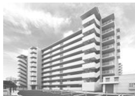
■市営住宅(建替住宅)
