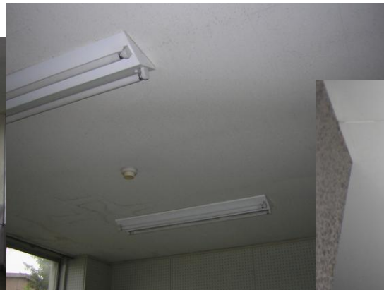
天井(岩綿吸音板)
