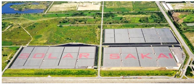
堺太陽光発電所（10MW）
