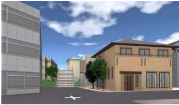
現況（令和元年 8 月時点）
