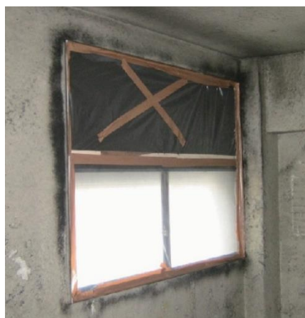
図 4.7.14 窓、換気口の負圧隔離養生例
