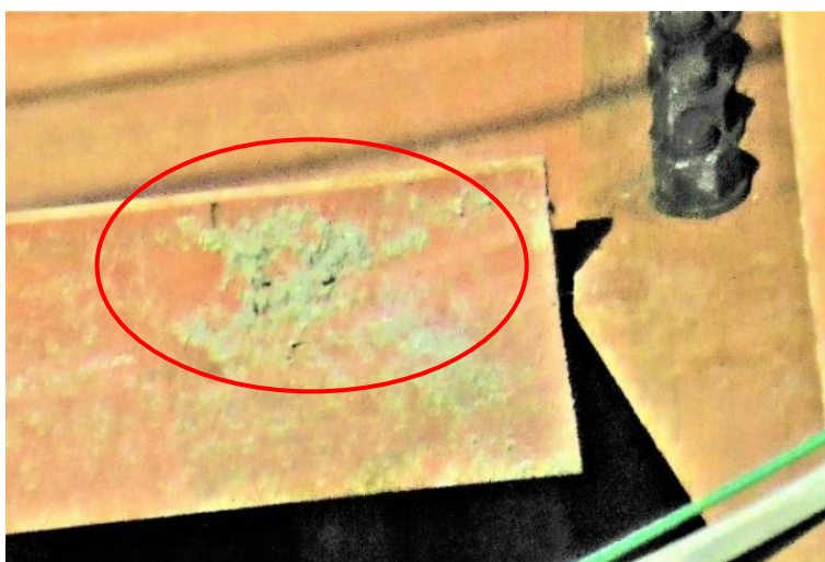
鉄骨梁下の取り残し
