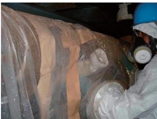
図 4.10.10 石綿除去作業中 2
