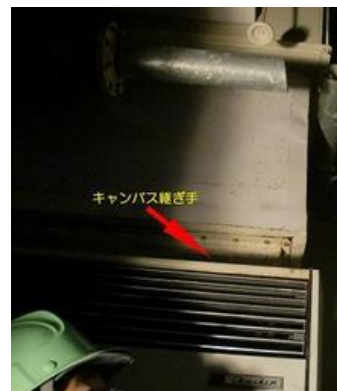
（参考資料）写真 6－11 キャンバス継ぎ手
