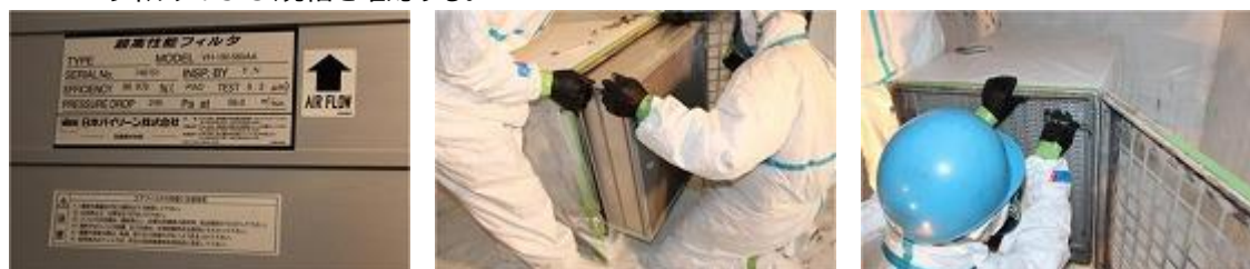
図 4.7.86 フィルタの取り付け
