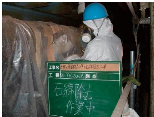
図 4.10.9 石綿除去作業中 1
