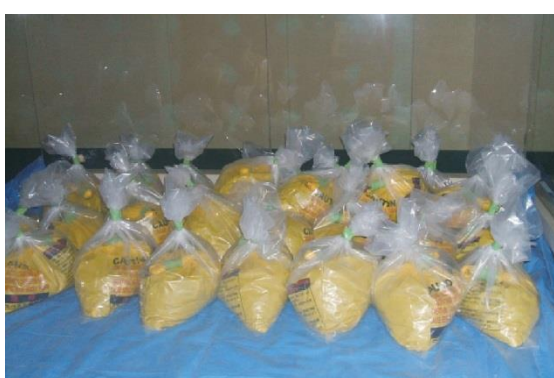
図 4.7.78 除去した石綿廃棄物の保管
