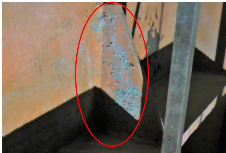
鉄骨梁側面の取り残し
