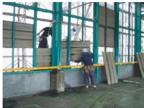
壁石綿含有成形板取外し
