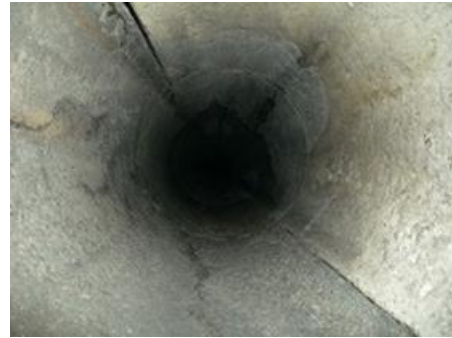
(参考資料) 写真 6-4 ハイスタック 煙突用断熱材 (2 分割)
