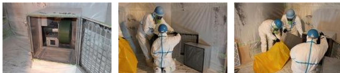
図 4.7.85 HEPAフィルタの交換
