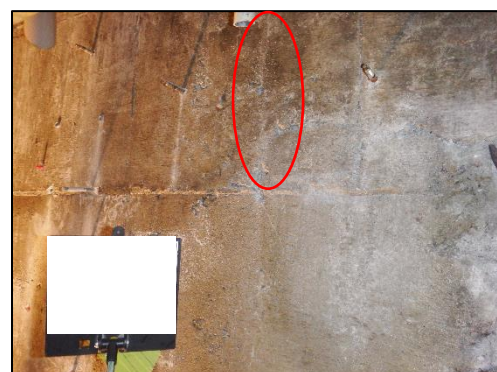
図4.15.10 取り残しの除去の確認
