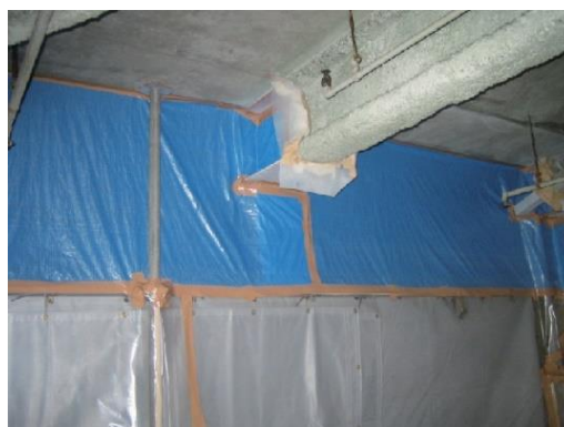
図 4.7.12 壁面の負圧隔離養生例（作業場内側）
