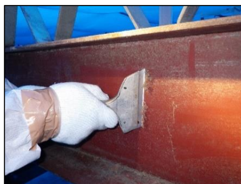
図4.15.5 再付着した石綿の除去
