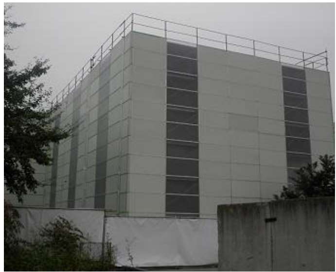
図 4.7.33 防音パネル／採光防音パネル施工例
