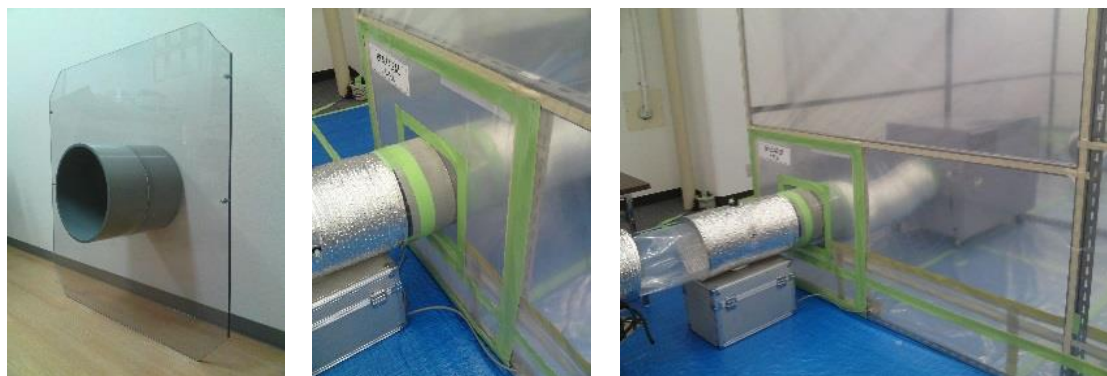
図4.14.14 排気ダクト貫通パネル例
