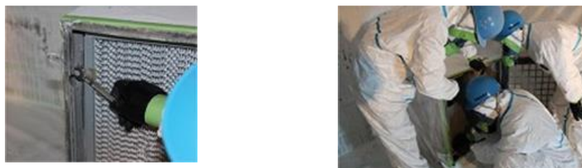
図 4.7.84 HEPAフィルタの留め付の緩み点検
