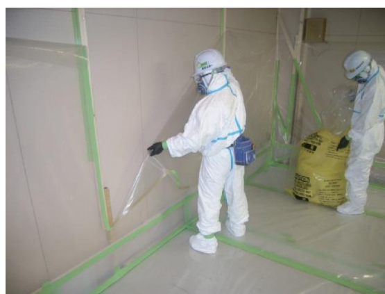
図 4.7.91 隔離シートの撤去
