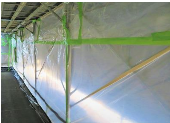
周囲への飛沫飛散防止養生例（内部）
