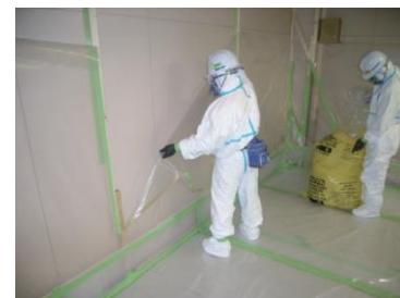
養生シートの撤去
